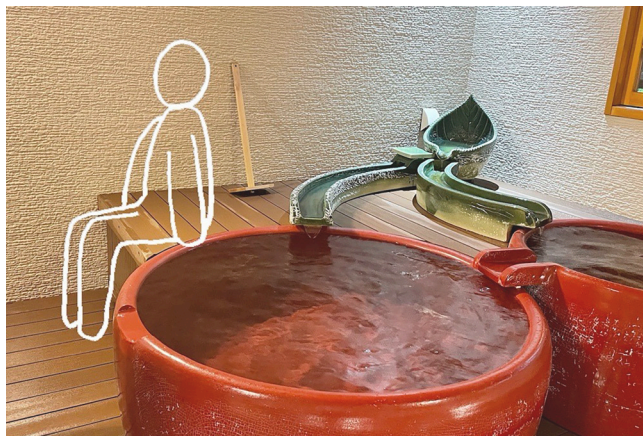
適切な高さを確保し、入浴時の移乗スペースを設けた事例。
