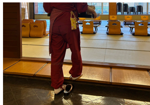
出入口の段差
